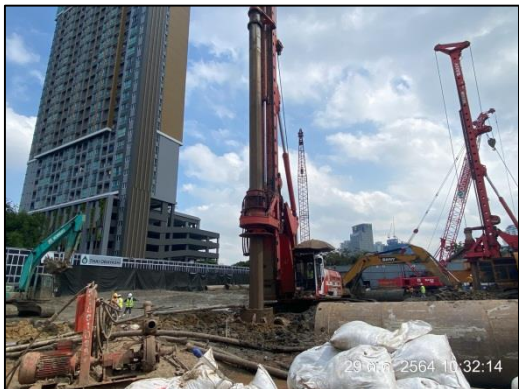
ภาพที่ 41 เส้าเข็มเจาะ
