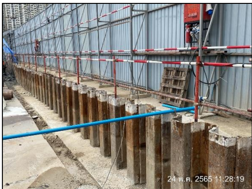
ภาพที่ 43 Sheet Pile
