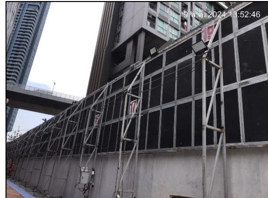
ภาพที่ 5 ติดตั้ง BLOXTEG i-TUFF บริเวณทิศเหนือของโครงการ
