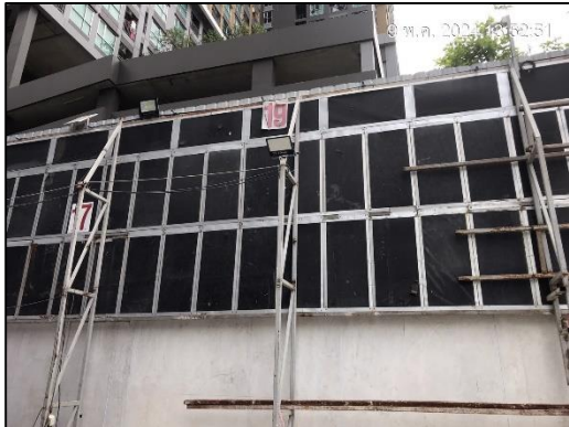
ภาพที่ 5 ติดตั้ง BLOXTEG i-TUFF บริเวณทิศเหนือของโครงการ
