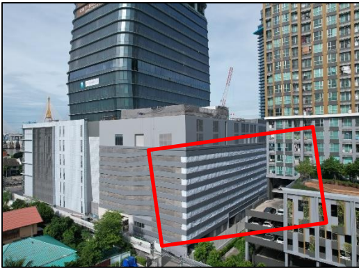
ภาพที่ 6 ผ้าใบป้องกันเสียง (Sound Proof Sheet)
