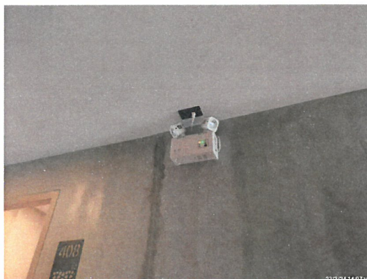
รูปที่ 2-34 แสดงระบบไฟส่องสว่างฉุกเฉิน (Emergency light) บริเวณบันไดหลัก และบริเวณทางเดินแต่ละชั้นของโครงการ
