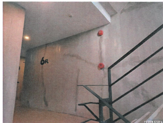
รูปที่ 2-35 แสดงกริ่งสัญญาณเตือนภัย และเครื่องแจ้งเหตุโดยใช้อีกด บริเวณภายในอาคาร
