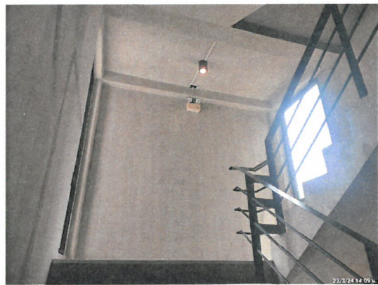
รูปที่ 2-34 แสดงระบบไฟส่องสว่างฉุกเฉิน (Emergency light) บริเวณบันไดหลัก และบริเวณทางเดินแต่ละชั้นของโครงการ
