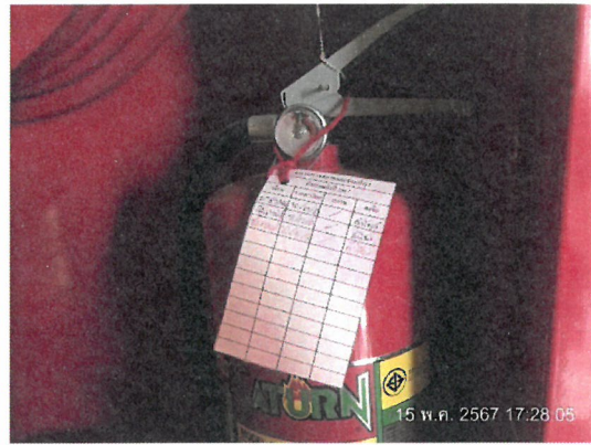
รูปที่ 2-39 แสดงการตรวจสอบอุปกรณ์ดับเพลิงภายในโครงการ
