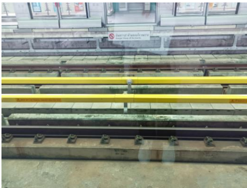
รูปที่ 2-32 หมุดยึดราง เฉพาะช่วงสะพานใหม่-ลำลูกกา คลอง 4
