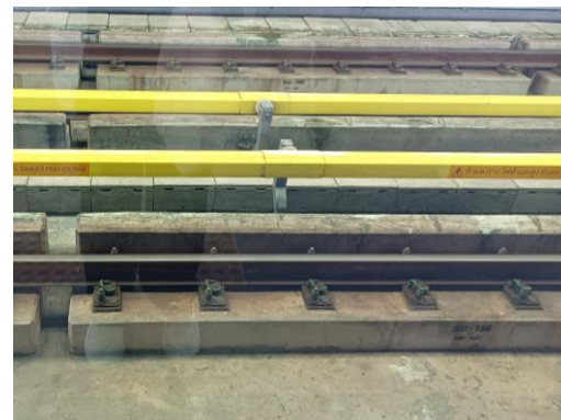
รูปที่ 2-4 หมุดยึดราง ช่วงหมอชิต-สะพานใหม่
