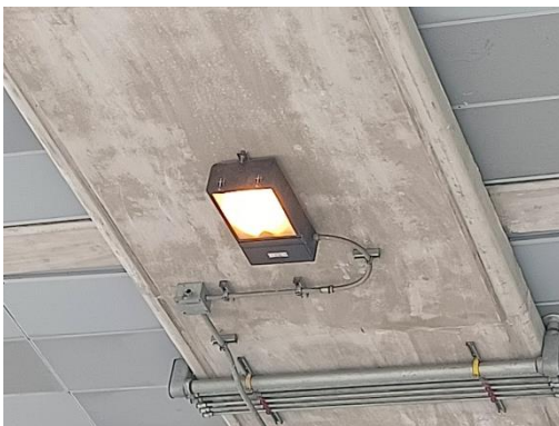
รูปที่ 2-36 ติดตั้งไฟส่องสว่างบริเวณใต้สถานีและด้านข้างริมทางเท้า
