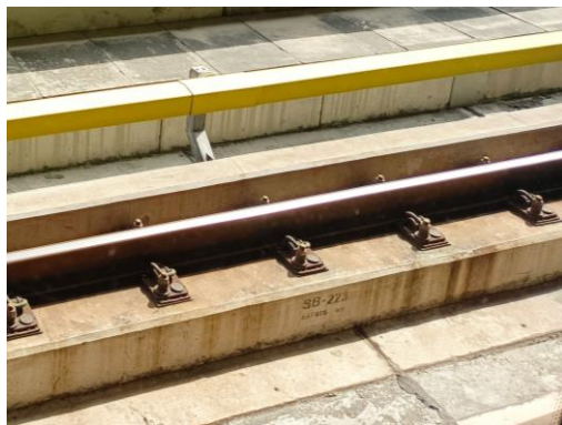
รูปที่ 2-4 หมุดยึดราง ช่วงหมอชิต-สะพานใหม่
