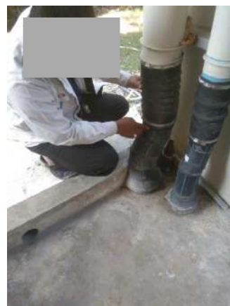
รูปที่ 2-53 ตรวจสอบการอุดตัน ความชำรุดของท่อระบายน้ำ
