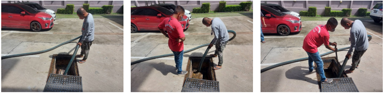
ภาพที่ 2.2-14 การสูบลบเกราะและบ่อดักไขมัน
