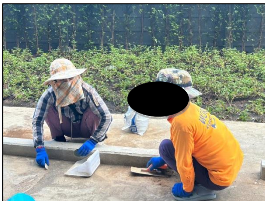
รูปที่ 40 คนงานสวมใส่เสื้อผ้าที่มิดชิด และสวมถุงมือทุกครั้งที่จะต้องสัมผัสผงปูนซีเมนต์
