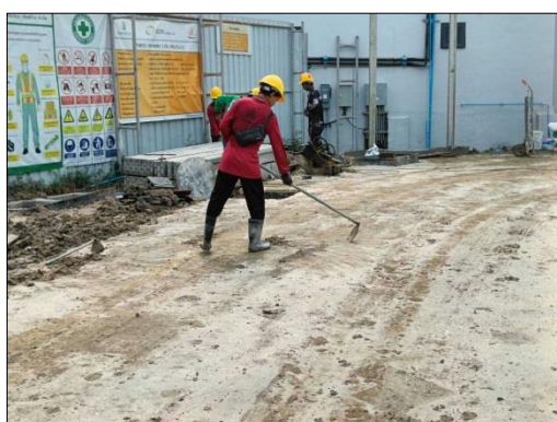
รูปที่ 15 คนงานควบคุมและลดปริมาณน้ำไหลและน้ำโคลนบนพื้นที่ก่อสร้าง
