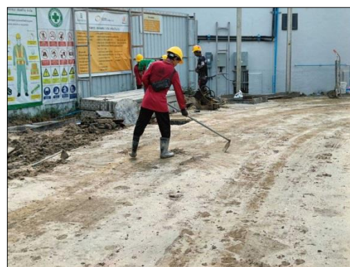
รูปที่ 15 คนงานควบคุมและลดปริมาณน้ำไหลและน้ำโคลนบนพื้นที่ก่อสร้าง
