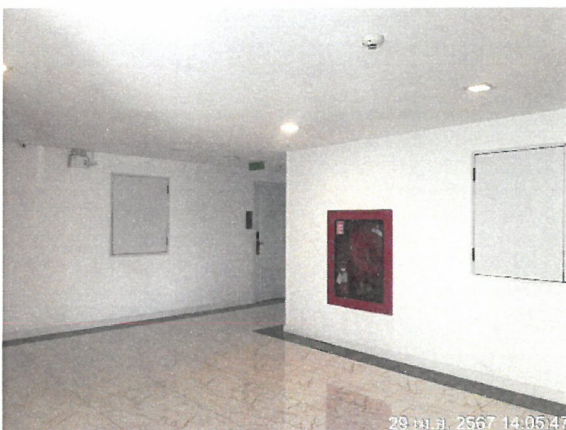
รูปที่ 2-43 แสดงตู้เก็บสายฉีดน้ำดับเพลิง (Fire Hose Cabinet) และถังดับเพลิงแบบมือถือ
