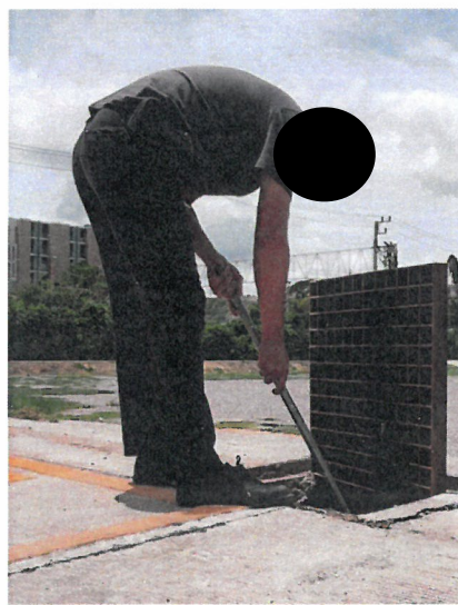
รูปที่ 2-18 แสดงบ่อพักน้ำ, ตะแกรงดักมูลฝอย บริเวณจุดระบายน้ำออกจากท่อระบายน้ำของโครงการ และเจ้าหน้าที่ขุดลอกท่อระบายน้ำภายในโครงการ
