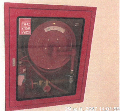
รูปที่ 2-43 แสดงตู้เก็บสายฉีดน้ำดับเพลิง (Fire Hose Cabinet) และถังดับเพลิงแบบมือถือ
