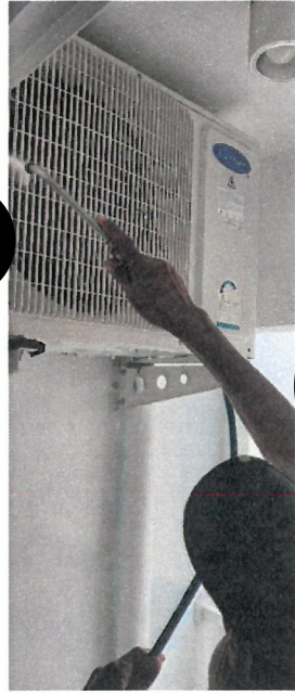
รูปที่ 2-22 แสดงเจ้าหน้าที่ทำความสะอาดเครื่องปรับอากาศภายในโครงการ
