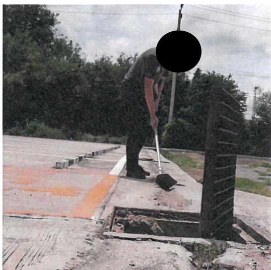
รูปที่ 2-18 แสดงบ่อพักน้ำ, ตะแกรงดักมูลฝอย บริเวณจุดระบายน้ำออกจากท่อระบายน้ำของโครงการ และเจ้าหน้าที่ขุดลอกท่อระบายน้ำภายในโครงการ
