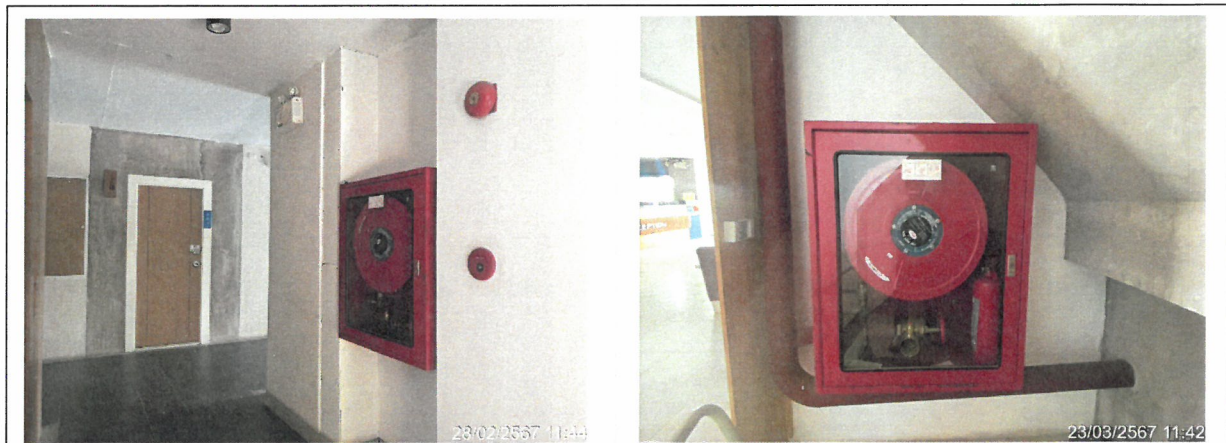
รูปที่ 2-35 แสดงตู้เก็บสายฉีดน้ำดับเพลิง (Fire Hose Cabinet) และถังดับเพลิงแบบมือถือ
