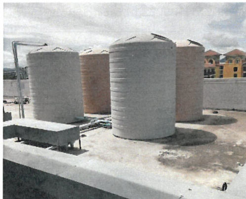
รูปที่ 2-7 แสดงถังเก็บน้ำใต้ดิน และถังสำรองน้ำชั้นดาดฟ้า
