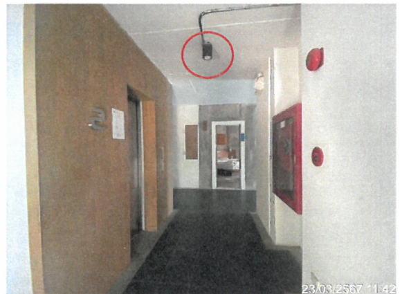
รูปที่ 2-22 แสดงการติดตั้งโคมไฟดาวนไลท์บริเวณทางเดินภายในอาคาร หน้าห้องพัก บันได และบริเวณด้านหลังห้องพัก
