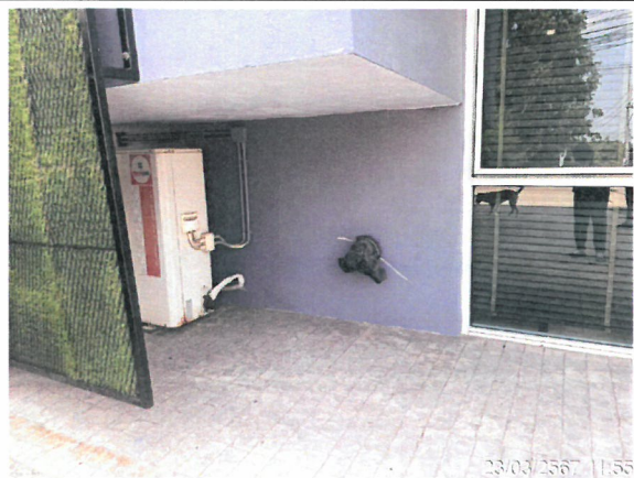
รูปที่ 2-39 แสดงติดตั้งหัวรับน้ำดับเพลิง FDC บริเวณที่จอดรถด้านข้างอาคารโครงการ
