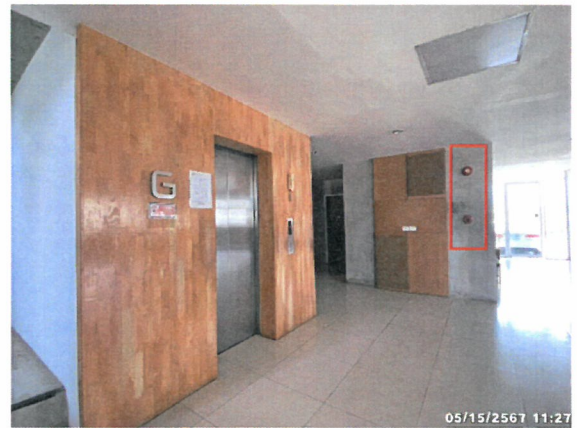
รูปที่ 2-38 แสดงกริ่งสัญญาณเตือนภัย (Alarm Bell) และเครื่องแจ้งเหตุโดยไข่มือกด (Fire Manual Station Unit)
