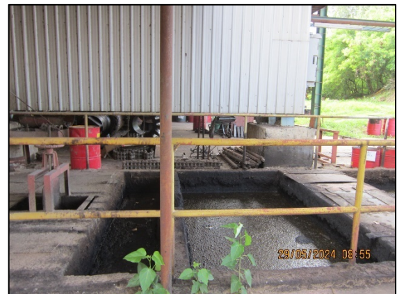
ภาพที่ 2.2-22 บ่อแยกน้ำ-น้ำมัน (Oil Separator)
