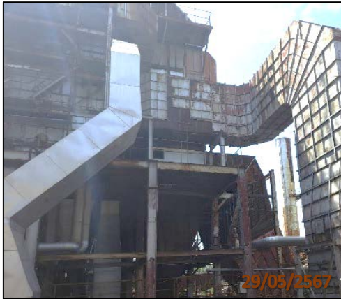
ภาพที่ 2.2-1 ระบบดักฝุ่นแบบมัลติไซโคลน
