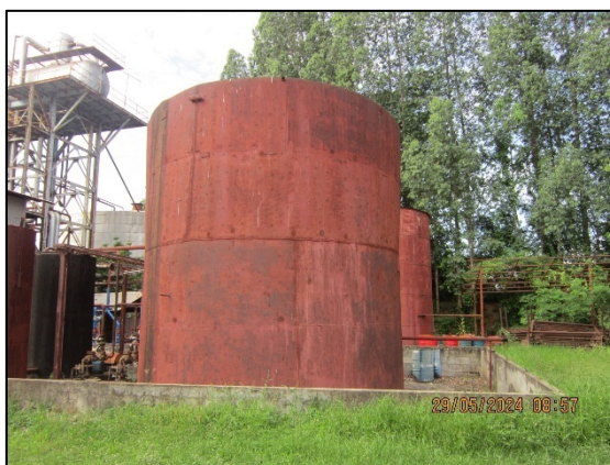
ภาพที่ 2.2-16 คันคอนกรีตล้อมรอบลานถ้ำน้ำมันเตา
