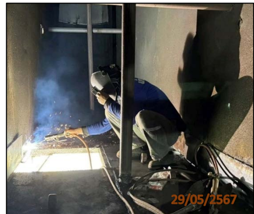
ภาพที่ 2.2-3 การซ่อมบำรุงระบบบำบัดมลพิษทางอากาศ
