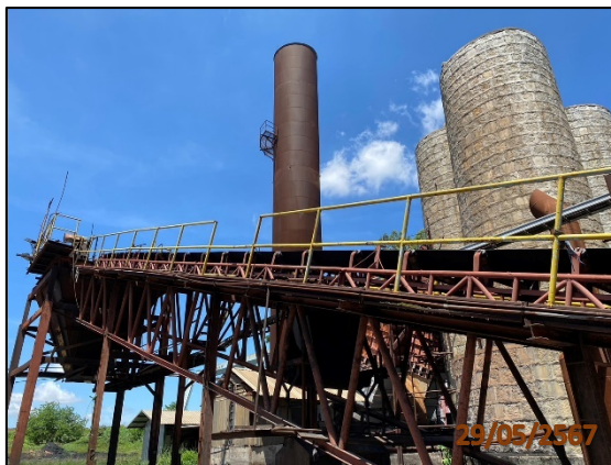
ภาพที่ 2.2-14 ระบบสายพานลำเลียงขี้เถ้า
