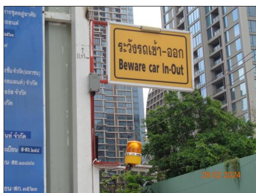
รูปที่ 23 สัญญาณไฟกระพริบและป้ายจราจรชั่วคราวบริเวณทางเข้า-ออกโครงการ
