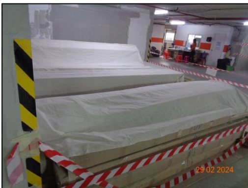
รูปที่ 5 ผ้าใบปิดคลุมกองวัสดุหรือเศษวัสดุที่เหลือ และการขนย้ายวัสดุออกจากพื้นที่ก่อสร้าง
