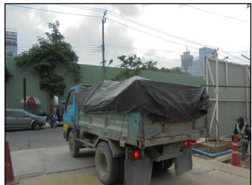
รูปที่ 5 ผ้าใบปิดคลุมกองวัสดุหรือเศษวัสดุที่เหลือ และการขนย้ายวัสดุออกจากพื้นที่ก่อสร้าง
