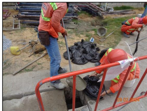
รูปที่ 34 คนงานขุดลอกตะกอนที่สะสมในบ่อพักน้ำ
