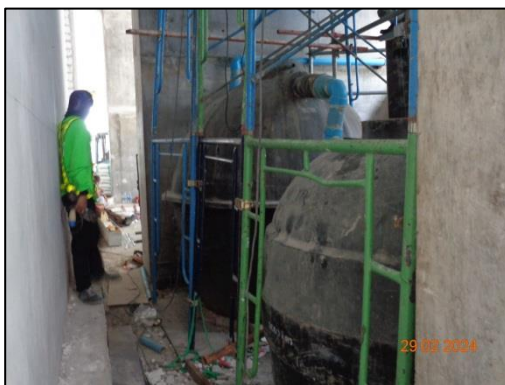
รูปที่ 13 ถังบำบัดน้ำเสียสำเร็จรูป
