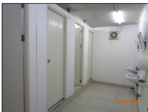
รูปที่ 12 ห้องส้วมสำหรับคนงานก่อสร้างที่ถูกหลักสุขาภิบาล
