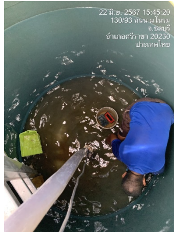
ภาพที่ 2.2-17 การล้างถังเก็บน้ำใช้
