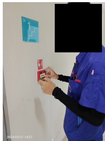
ภาพที่ 2.2-14 การตรวจเช็คอุปกรณ์ดับเพลิง
