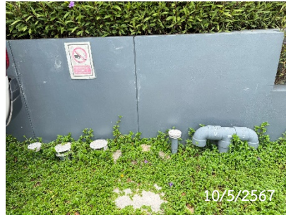
ท่อระบายอากาศและท่อเติมอากาศ
