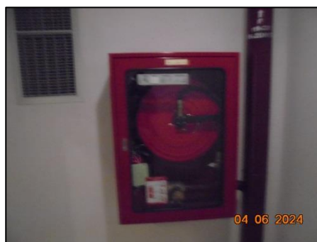
รูปที่ 28 ตู้เก็บสายฉีดน้ำดับเพลิงพร้อมอุปกรณ์ (FHC)
