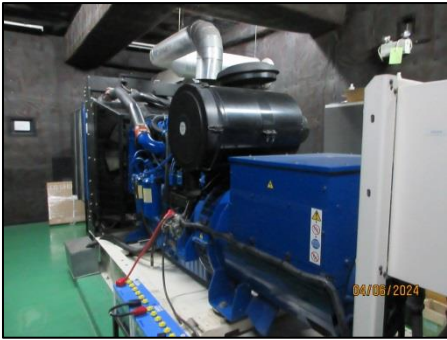
รูปที่ 23 เครื่องกำเนิดไฟฟ้าฉุกเฉิน (Generator) ขนาด 500 KVA จำนวน 1 เครื่อง
