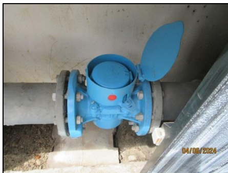
รูปที่ 12 ท่อรับน้ำประปาจากการประปานครหลวง
