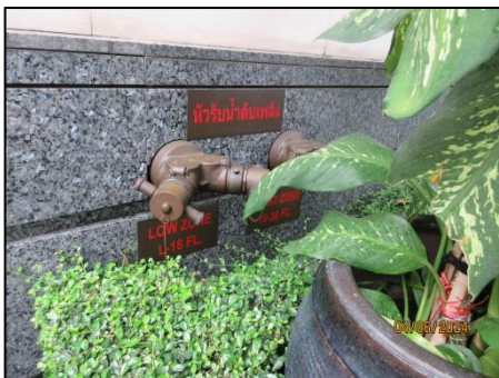
รูปที่ 29 หัวรับน้ำดับเพลิงภายนอกอาคารชุดคิวหลังสวน
