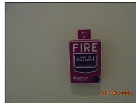
รูปที่ 37 Fire Alarm Bell และ Fire Alarm Manual Station ภายในอาคารชุดกิวหลังสวน
