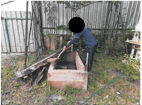
รูปที่ 2-25 แสดงการติดตั้งท่อระบายน้ำ สำหรับรวบรวมน้ำเข้าสู่บ่อพัก พร้อมทั้งจัดเจ้าหน้าที่ขุดลอก ตะกอนดินที่สะสมในบ่อพัก
