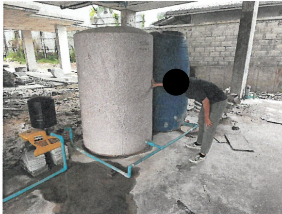
รูปที่ 2-21 แสดงเจ้าหน้าที่ตรวจสอบจุดรั่วซึมของถังเก็บน้ำสำรองภายในพื้นที่ก่อสร้าง
