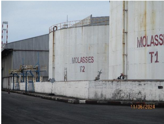
รูปที่ 2-1 คันกันป้องกันการรั่วไหลโดยรอบถังเก็บกากน้ำตาล
