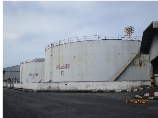
รูปที่ 2-1 คันกันป้องกันการรั่วไหลโดยรอบถังเก็บกากน้ำตาล
