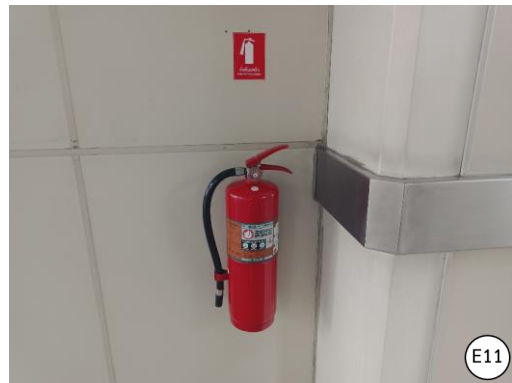
รูปที่ 2-37 การติดตั้งอุปกรณ์ดับเพลิง บริเวณสถานี E10-E14
