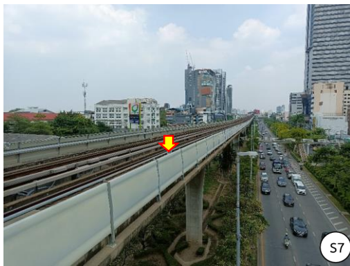
รูปที่ 2-1 กำแพงกันเสียงสูง 1.20 เมตร ตลอดสองข้างทางของรางรถไฟฟ้า บริเวณสถานี S7-S8
