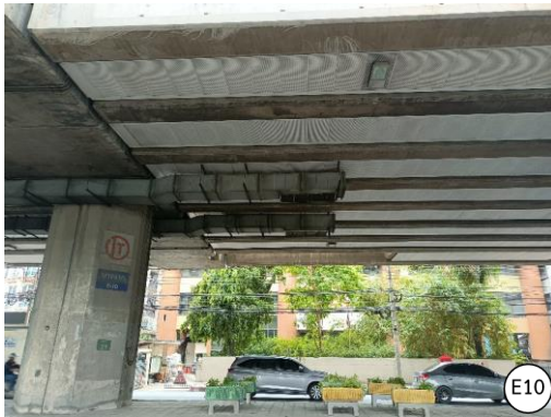
รูปที่ 2-20 ระบบระบายอากาศใต้สถานีบางจาก
