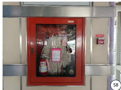
รูปที่ 2-16 การติดตั้งอุปกรณ์ดับเพลิง บริเวณสถานี S7-S8
