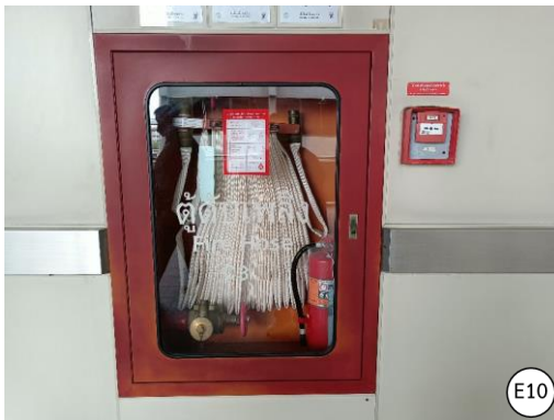
รูปที่ 2-37 การติดตั้งอุปกรณ์ดับเพลิง บริเวณสถานี E10-E14
