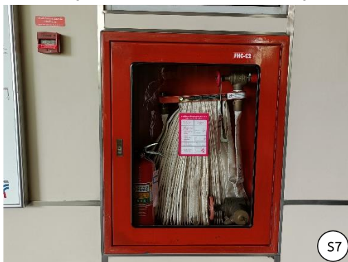
รูปที่ 2-16 การติดตั้งอุปกรณ์ดับเพลิง บริเวณสถานี S7-S8
