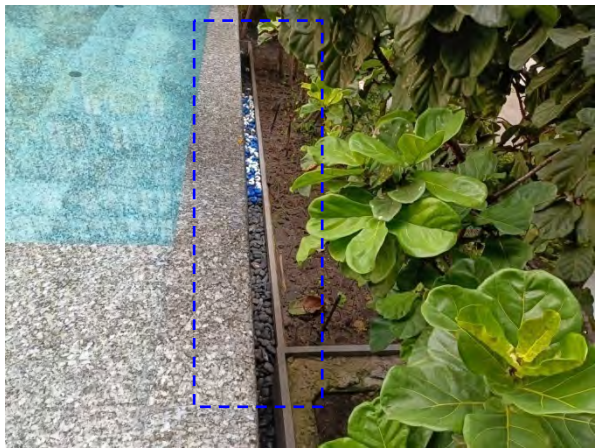
รูปที่ 2-39 รางระบายน้ำล้นรอบสระว่ายน้ำ
