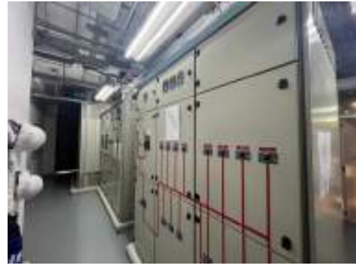
รูปที่ 2-41 ห้องหม้อแปลงไฟฟ้า
