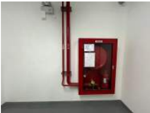
รูปที่ 2-38 ตู้เก็บอุปกรณ์ดับเพลิง
