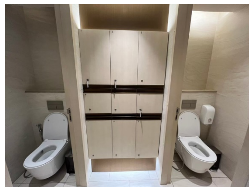
รูปที่ 2-13 เลือกใช้สุขภัณฑ์ที่ประหยัดน้ำหรืออุปกรณ์ที่มีประสิทธิภาพสูงทั้งก๊อกประหยัดน้ำชักโครก และหัวฉีดประหยัดน้ำ
