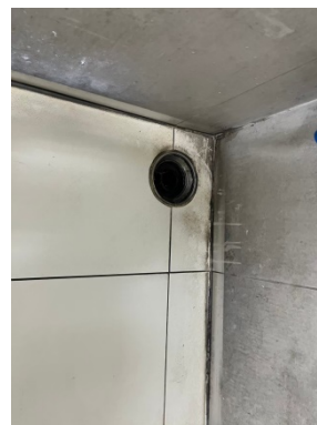
รูปที่ 2-33 ท่อรวบรวมน้ำเสียที่เกิดจากการล้างห้องพักมูลฝอยรวมเข้าสู่ระบบบำบัดน้ำเสีย
