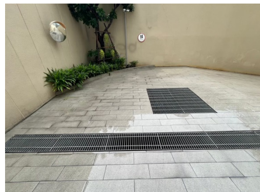
รูปที่ 2-50 ตะแกรงครอบตามรูปท่อระบายน้ำทั้งภายในและภายนอกอาคาร
