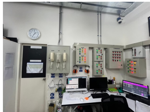
โทรศัพท์ฉุกเฉิน (Fire Fighters Telephone Jack)
