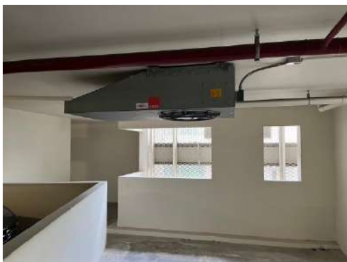
รูปที่ 2-3 พื้นที่จอดรถของโครงการมีป้ายจำกัดความสูง ลูกศรชี้ทาง ป้ายห้ามติดเครื่องยนต์ทิ้งไว้ พื้นที่จอดรถเป็นระบบระบายอากาศทั้งแบบธรรมชาติ และติดตั้งพัดลมระบายอากาศ
