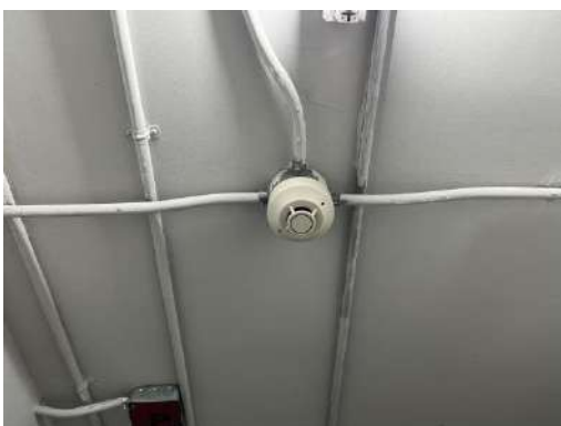
รูปที่ 2-12 ห้องหม้อแปลงไฟฟ้า ติดตั้งเครื่องตรวจจับควัน และความร้อน ติดป้ายแสดงอันตรายไฟฟ้าแรงสูง
