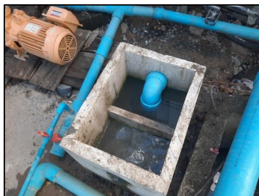
รูปที่ 32 รายละเอียดน้ำและท่อระบายน้ำชั่วคราวของโครงการ
