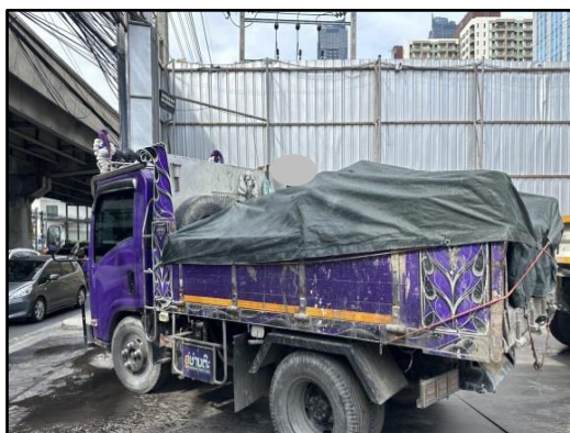
รูปที่ 14 การปิดคลุมรถบรรทุกด้วยผ้าใบก่อนออกจากโครงการ
