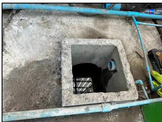
รูปที่ 32 รายละเอียดน้ำและท่อระบายน้ำชั่วคราวของโครงการ
