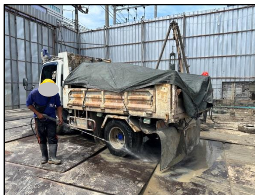
รูปที่ 14 การปิดคลุมรถบรรทุกด้วยผ้าใบก่อนออกจากโครงการ
