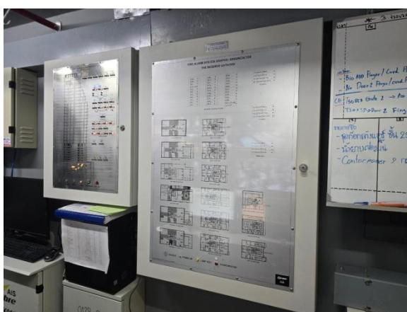
แผงควบคุม Fire Alarm
