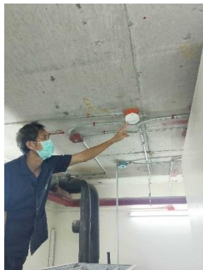
ตรวจสอบ Heat Detector
