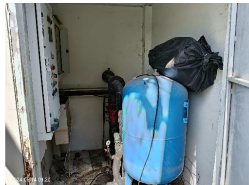
ตู้ควบคุมการสูบน้ำในบ่อหน่วงน้ำฝน
