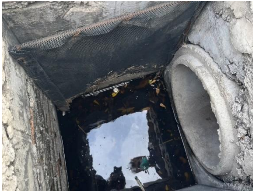
ตะแกรงดักขยะ ก่อนปล่อยน้ำออกนอกโครงการ
