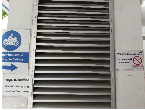
ช่องเปิดระบายอากาศบันไดหนีไฟ
