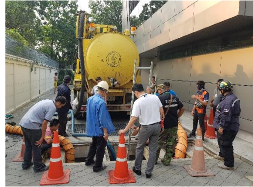
การสูบน้ำก่อนส่วนเกินระบบบำบัดน้ำเสีย
