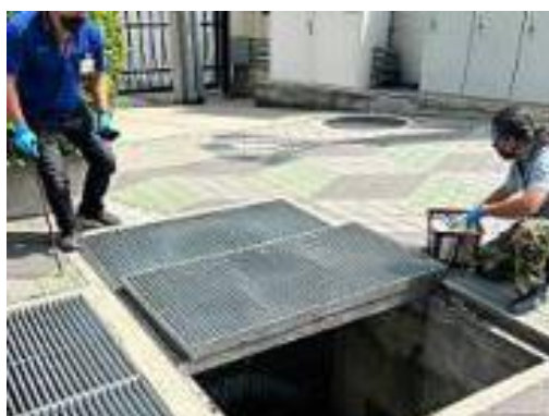
จุดบ่อพักน้ำสุดท้ายก่อนระบายลงรางสาธารณะ
