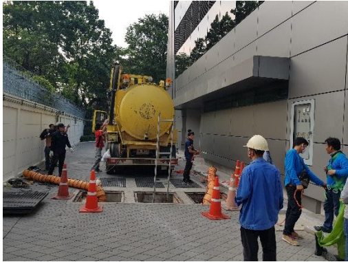
การสูบน้ำก่อนส่วนเกินระบบบำบัดน้ำเสีย
