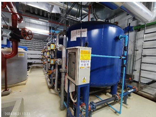
ระบบกรองน้ำที่ผ่านการบำบัดแล้ว
