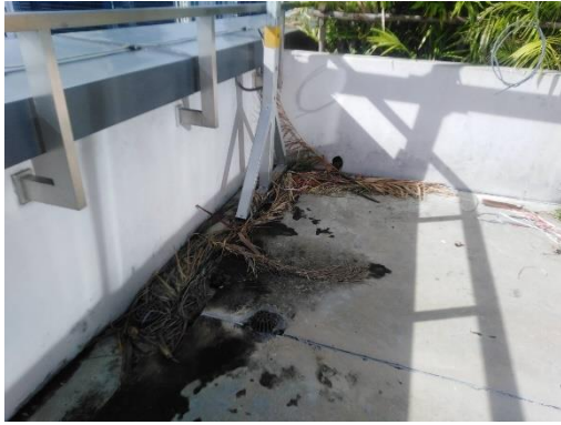
การทำความสะอาดและตัดเศษขยะออกจากตะแกรงดักขยะ
