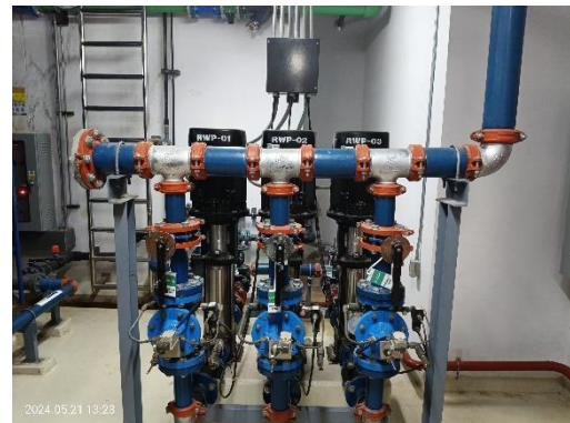
เครื่องสูบน้ำ Reuse
