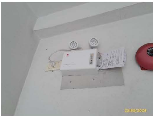
Battery ไฟฟ้าสำรอง
