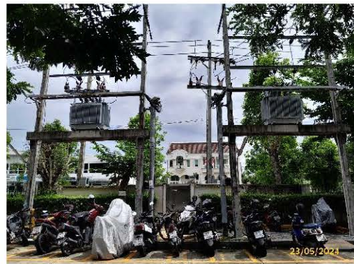
หม้อแปลงไฟฟ้าประจำอาคาร
