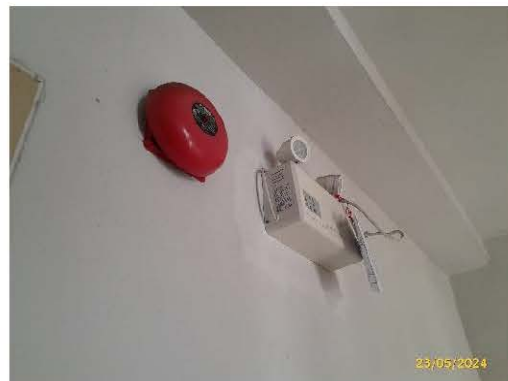
Battery ไฟฟ้าสำรอง
