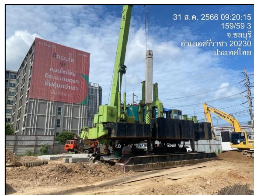
รูปที่ 28 การใช้เสาเข็มแบบเข็มกด (Jack-in Pile)
