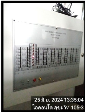
แผงควบคุม Fire Alarm
