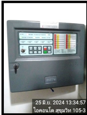
แผงควบคุม Fire Alarm
