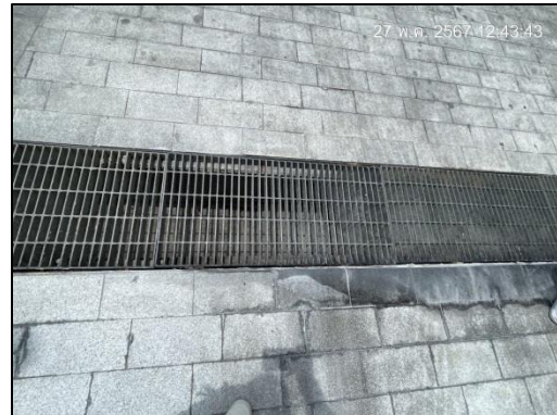
รูปที่ 47 (ต่อ) ระบบระบายน้ำ ท่อระบายน้ำ โครงสร้างคอนกรีตเสริมเหล็ก รอบพื้นที่โครงการ
