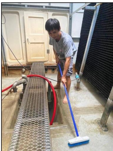
รูปที่ 12 (ต่อ) เจ้าหน้าที่ทำความสะอาด บำรุงรักษาหรือซ่อมแซมหอหล่อเย็น (Cooling Tower) และห้องทำความเย็น (Chiller Room)
