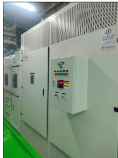
รูปที่ 38 หม้อแปลงไฟฟ้า
