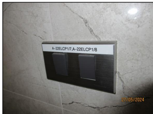
รูปที่ 40 สวิตช์ไฟแยกออกจากกัน สามารถเปิด-ปิดได้เฉพาะจุด
