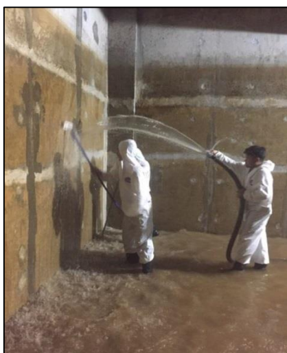
รูปที่ 34 ดำเนินการทำความสะอาดถึงเก็บน้ำสำรอง
