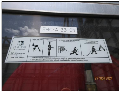
รูปที่ 68 (ต่อ) ตู้เก็บสายฉีดน้ำดับเพลิงพร้อมอุปกรณ์ถังดับเพลิงและป้ายวิธีการใช้
