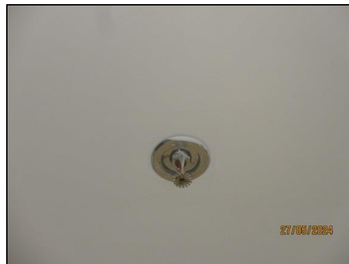
รูปที่ 67 ระบบหัวกระจายน้ำดับเพลิงอัตโนมัติ
