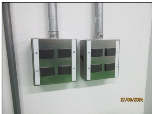
รูปที่ 40 สวิตช์ไฟแยกออกจากกัน สามารถเปิด-ปิดได้เฉพาะจุด
