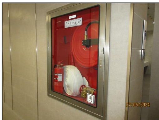
รูปที่ 68 (ต่อ) ตู้เก็บสายฉีดน้ำดับเพลิงพร้อมอุปกรณ์ถังดับเพลิงและป้ายวิธีการใช้
