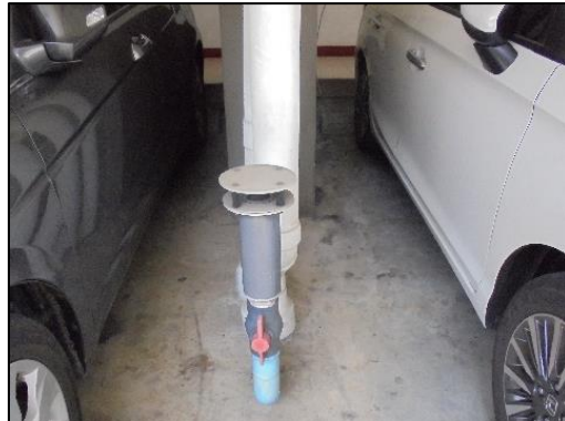
รูปที่ 38 ตัวกรองชีวภาพ (Biofilter) และ Gas Burner System สำหรับกำจัดก๊าซมีเทน
