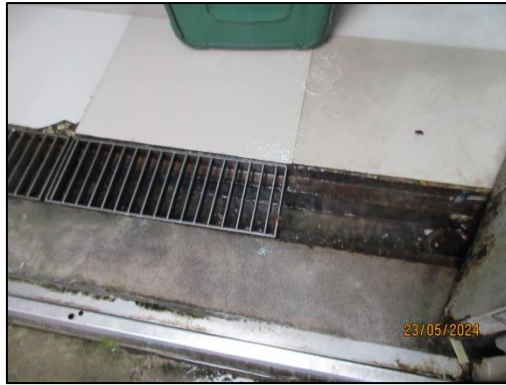
รูปที่ 36 รางระบายน้ำภายในห้องพักรถส่วนกลาง
