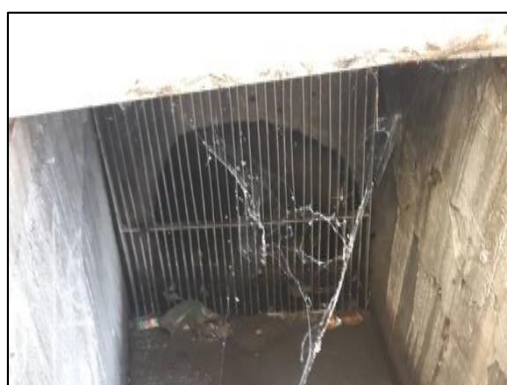
รูปที่ 14 ตะแกรงดักขยะที่บ่อพักน้ำ
