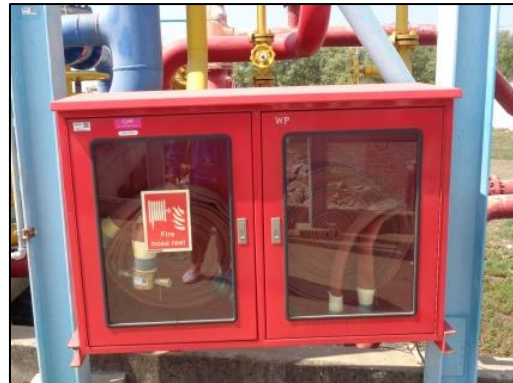
รูปที่ 15 สายฉีดน้ำดับเพลิง
