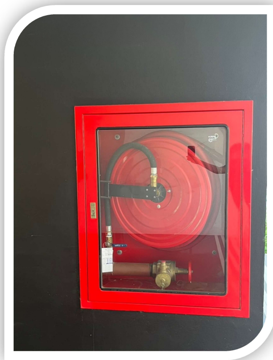
ภาพที่ 28 แสดงตู้เก็บสายน้ำดับเพลิง-ถังดับเพลิงแสดงถังดับเพลิง
