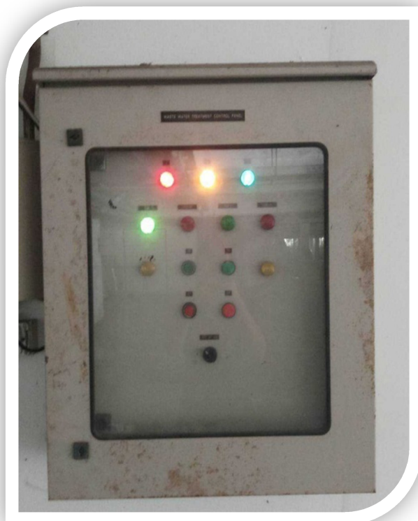
ภาพที่ 31 แสดงตู้คอนโทรลควบคุมการทำงานของระบบน้ำเสีย
