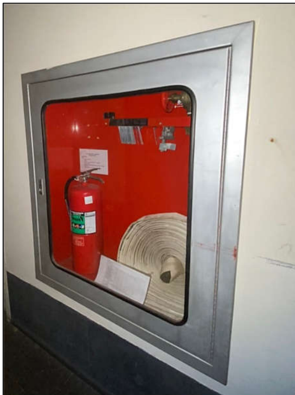
ภาพที่ 27 แสดงตู้เก็บสายน้ำดับเพลิง-ถังดับเพลิง
