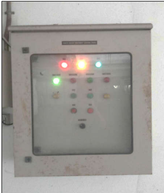
ภาพที่ 49 แสดงตู้คอนโทรลควบคุมการทำงานของเครื่องเติมอากาศ (ฝั่ง โรงแรมวีรันดา)
