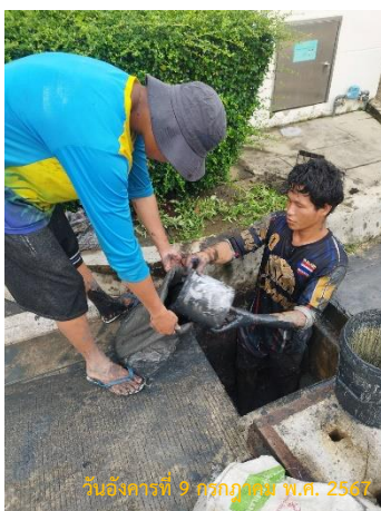
ภาพที่ 2-25 การขุดลอกท่อระบายน้ำของโครงการ
