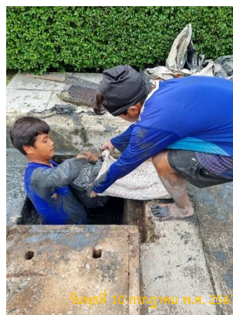
ภาพที่ 2-25 การขุดลอกท่อระบายน้ำของโครงการ
