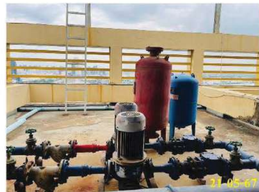
ถังเก็บน้ำคาดฟ้า พร้อมเครื่องปั้มน้ำ
