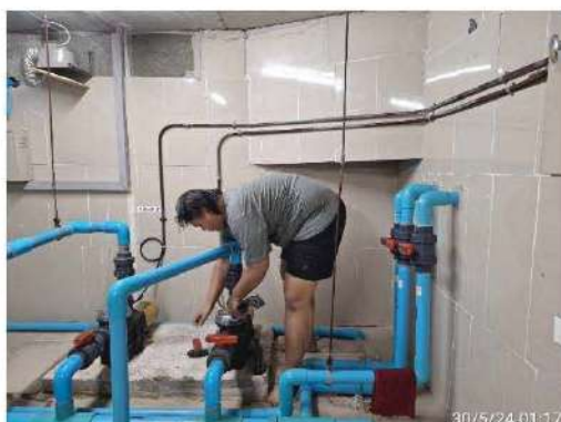
ช่างทำความสะอาดเครื่องกรองน้ำสระว่ายน้ำ
