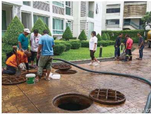
สับตะกอนระบบบำบัดน้ำเสีย
