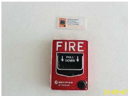
ชุดกดแจ้งเหตุแบบใช้มือ (Manual Station)
