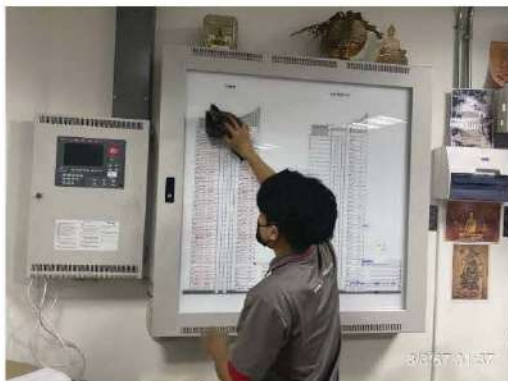
ช่างตรวจเช็ค และบำรุงรักษาอุปกรณ์ป้องกันและแจ้งเหตุเพลิงไหม้
