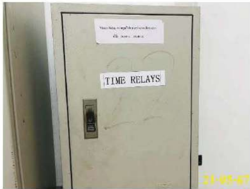
ระบบควบคุมไฟฟ้าส่องสว่างพื้นที่ส่วนกลาง (TIMER Delay)
