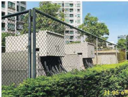
หม้อแปลงไฟฟ้า ขนาด 1,600 KVA อาคาร A
