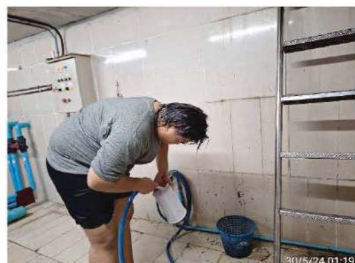
ช่างทำความสะอาดเครื่องกรองน้ำสระว่ายน้ำ
