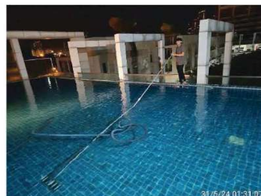
ช่างดำเนินการสูบลบตะกอนสระว่ายน้ำ
