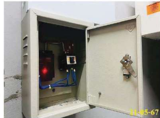
ระบบควบคุมไฟฟ้าส่องสว่างพื้นที่ส่วนกลาง (TIMER Delay)
