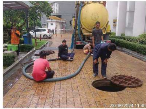
สับตะกอนระบบบำบัดน้ำเสีย
