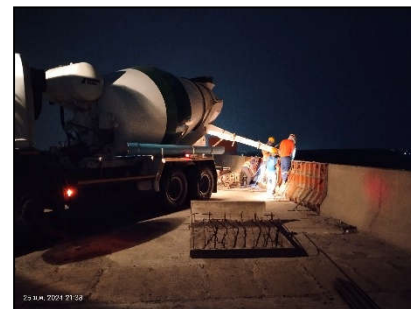
การเทปูนราดสะพาน โครงการฯ ตอน บางขุนเทียน-เอกชัย ตอน 3 กม.19+500
