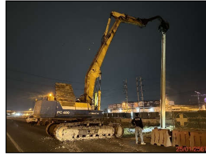
การปัก Sheet Pile โครงการฯ ตอน เอกชัย-บ้านแพ้ว ตอน 8 กม.31+700
