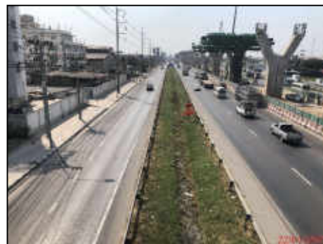
รางระบายน้ำที่เกาะแบ่งช่องทางหลักกับทางขนาน (SEPARATOR) ก่อสร้างแล้วเสร็จ กม.35+200 (ขวาทาง)
