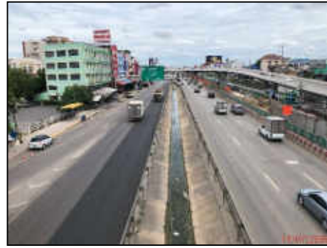
รางระบายน้ำที่เกาะแบ่งช่องทางการหลักกับทางขนาน (SEPARATOR) ก่อสร้างแล้วเสร็จ กม.27+800 (ซ้ายทาง)
