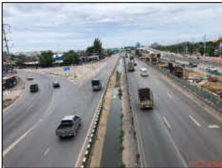
รางระบายน้ำที่เกาะแบ่งช่องทางการหลักกับทางขนาน (SEPARATOR) ก่อสร้างแล้วเสร็จ กม.28+000 (ขวาทาง)
