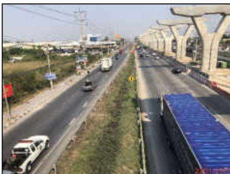
รางระบายน้ำที่เกาะแบ่งช่องทางหลักกับทางขนาน (SEPARATOR) ก่อสร้างแล้วเสร็จ กม.35+200 (ซ้ายทาง)
