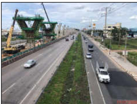
รางระบายน้ำที่เกาะแบ่งช่องทางการหลักกับทางขนาน (SEPARATOR) ก่อสร้างแล้วเสร็จ กม.34+900 (ขวาทาง)
