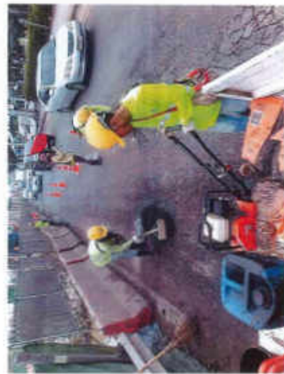
รูปบันทึกการดำเนินงานที่ 13.1 การอัดแน่นผิวหน้าจราจร วันที่ 16 ตุลาคม 2560
