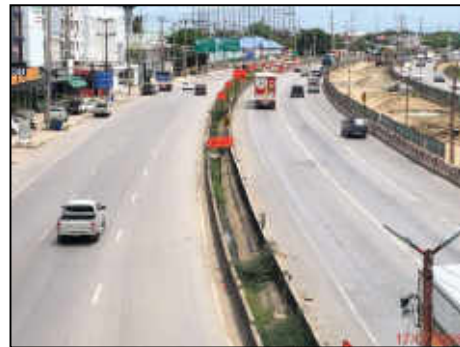
รางระบายน้ำที่เกาะแบ่งช่องทางการหลักกับทางขนาน (SEPARATOR) ก่อสร้างแล้วเสร็จ กม.30+200 (ซ้ายทาง)
