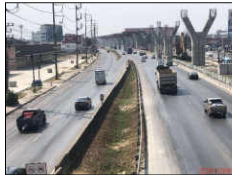
รางระบายน้ำที่เกาะแบ่งช่องทางหลักกับทางขนาน (SEPARATOR) ก่อสร้างแล้วเสร็จ กม.32+000 (ซ้ายทาง)
