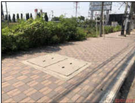
ท่อระบายน้ำบนทางเท้าที่ก่อสร้างแล้วเสร็จ กม.20+600 (ซ้ายทาง)
