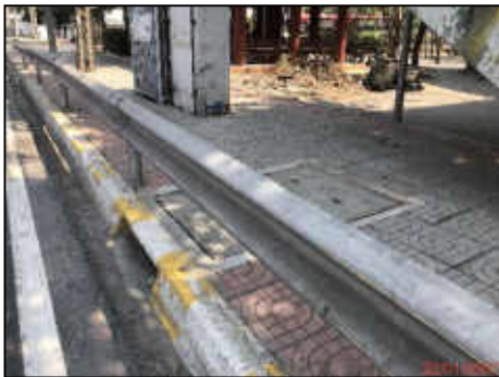
ท่อระบายน้ำบนทางเท้าที่ก่อสร้างแล้วเสร็จ กม.29+100 (ซ้ายทาง)
