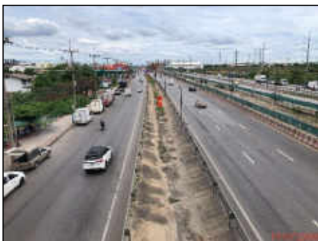
รางระบายน้ำที่เกาะแบ่งช่องทางหลักกับทางขนาน (SEPARATOR) ก่อสร้างแล้วเสร็จ กม.21+800 (ขวาทาง)
