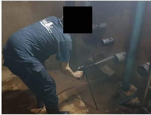
การทำความสะอาดถังเก็บน้ำ
