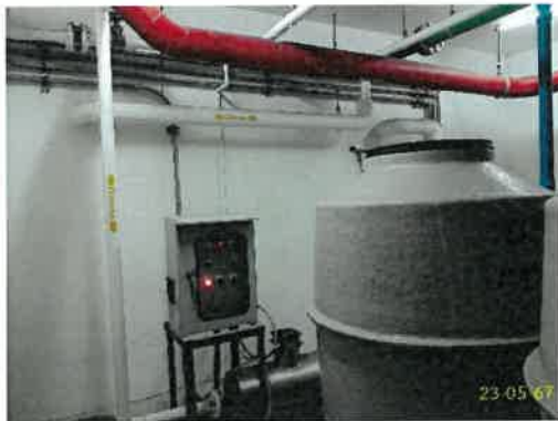
บำบัด Aerosol ด้วย Ozone ระบบบำบัดน้ำเสียชุดที่ 1 (ต่อ)
