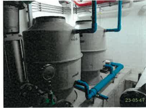
บำบัด Aerosol ด้วย Ozone ระบบบำบัดน้ำเสียชุดที่ 1 (ต่อ)
