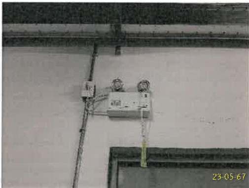
ไฟฟ้าแสงสว่างฉุกเฉิน
