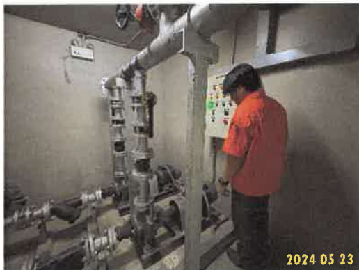
ภาพที่ 2-17 เจ้าหน้าที่ตรวจสอบระบบประปา
