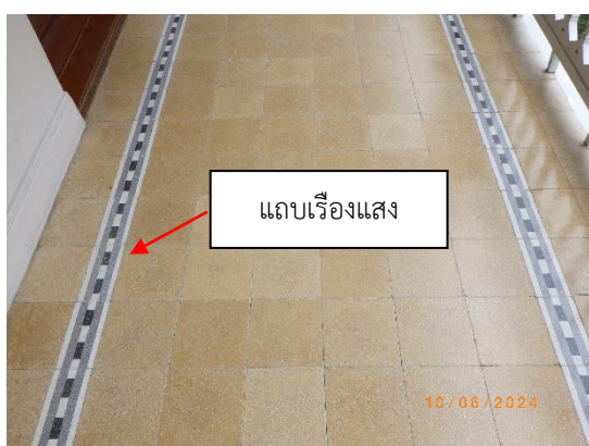
รูปที่ 2-26 แถบเรืองแสง นำทางหนีไฟ บริเวณพื้น ทางเดินภายในอาคาร
