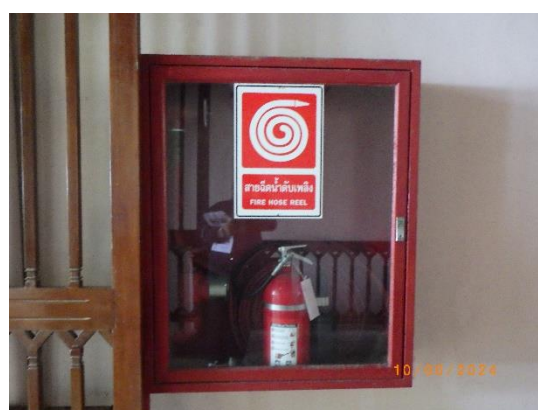
รูปที่ 2-27 ตู้จัดเก็บอุปกรณ์ดับเพลิง และสายส่งน้ำ ดับเพลิงภายในอาคาร
