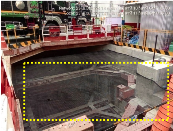
รูปที่ 2-57 ติดตั้งตาข่ายป้องกันการพลัดตก
