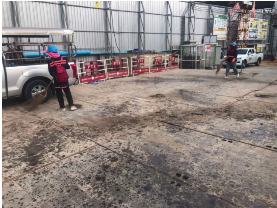
รูปที่ 2-17 คนงานฉีดพรมน้ำพื้นที่โครงการเพื่อลดฝุ่นละออง
