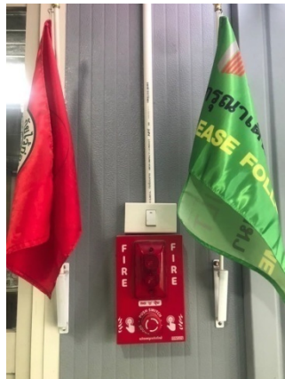
รูปที่ 2-66 อุปกรณ์แจ้งเหตุเพลิงไหม้ (Fire alarm)
