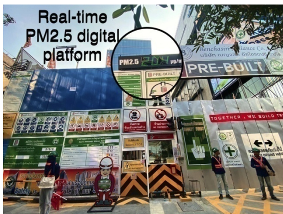
รูปที่ 2-15 ติดตั้งเครื่องตรวจวัดค่าฝุ่นละออง PM 2.5
