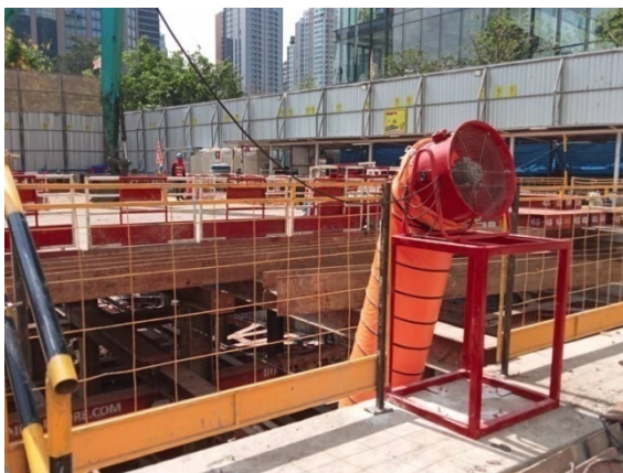
รูปที่ 2-58 ติดตั้งพัดลมระบายอากาศในพื้นที่อับอากาศ
