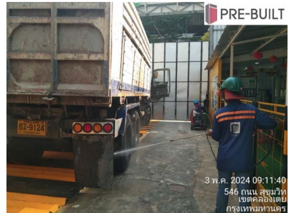
รูปที่ 2-11 ล้างล้อรถบรรทุกก่อนออกจากพื้นที่โครงการ
