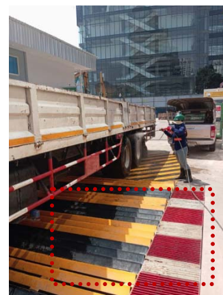
รูปที่ 2-11 ล้างล้อรถบรรทุกก่อนออกจากพื้นที่โครงการ
