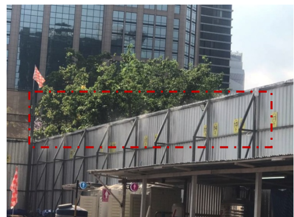
รูปที่ 2-16 ติดตั้งละอองน้ำเพื่อลดฝุ่นละออง
