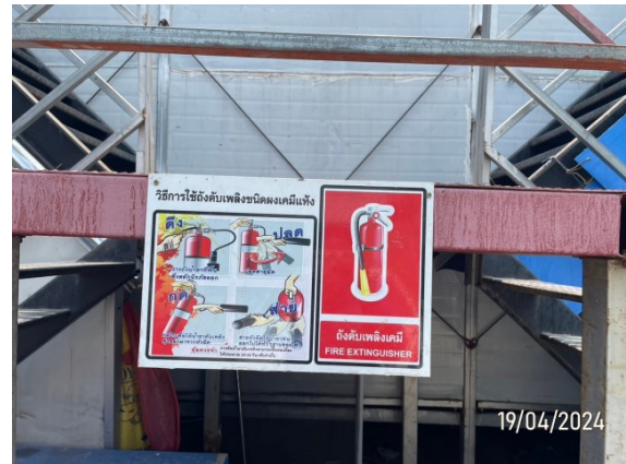
ถังดับเพลิงเคมีและวิธีการใช้งาน
