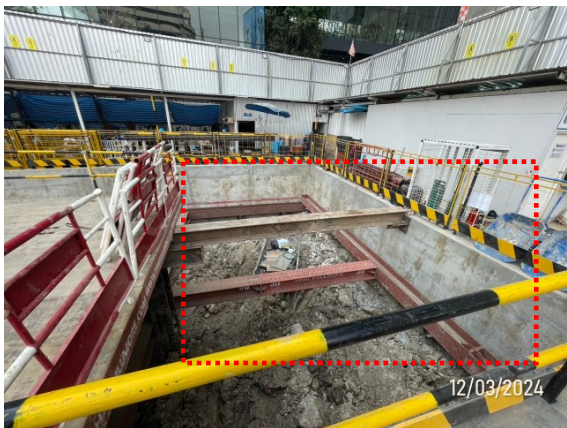
รูปที่ 2-7 กำแพงกันดิน (Diaphragm wall)/ค้ำยัน ช่วงงานโครงสร้างชั้นใต้ดิน
