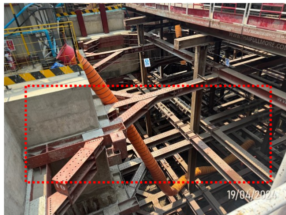
รูปที่ 2-7 กำแพงกันดิน (Diaphragm wall)/ค้ำยัน ช่วงงานโครงสร้างชั้นใต้ดิน
