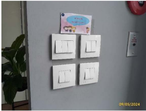
แยกสวิตช์ควบคุมอุปกรณ์ไฟฟ้าส่องสว่าง
