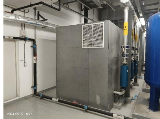
เครื่องเติมอากาศของระบบบำบัดน้ำเสีย
