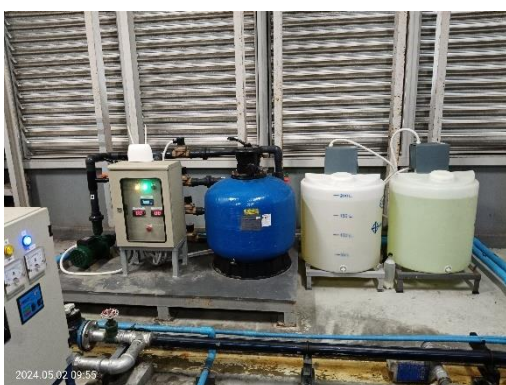
ระบบสำหรับควบคุมเชื้อลิจิโอนেলাในหอผึ่งเย็น
