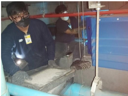
ตรวจสอบระบบ UV ที่คู่อากาศจากระบบบำบัดน้ำเสีย
