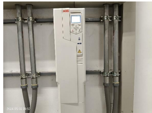
ระบบ VSD ควบคุมการสูบน้ำ
