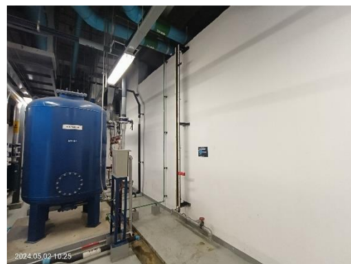
เครื่องกรองน้ำเพื่อทำเป็นน้ำ REUSE
