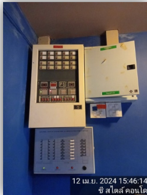
แผงควบคุม Fire Alarm
