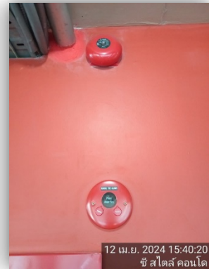
เครื่องแจ้งเหตุและกริ่งสัญญาณ
