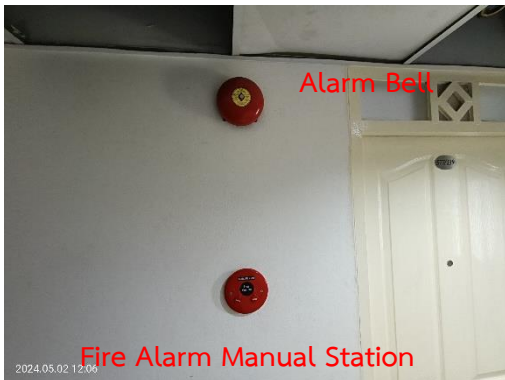
Fire Alarm Manual Station และ Alarm Bell
