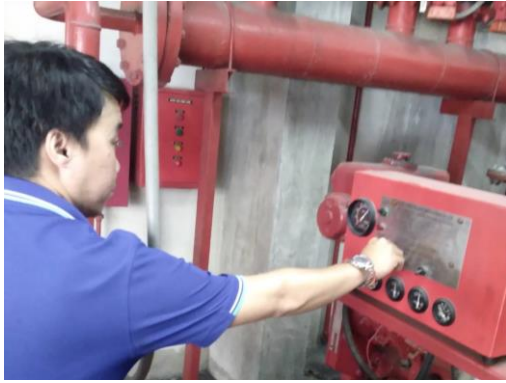
เจ้าหน้าที่ตรวจสอบปั้มน้ำดับเพลิง
