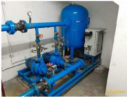
ถังเก็บน้ำ พร้อมเครื่องปั้มน้ำขึ้นตาดฟ้า
