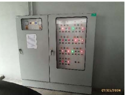
พื้นที่ระบบบำบัดน้ำเสีย พร้อมตู้ควบคุมระบบบำบัดน้ำเสียอาคาร B
