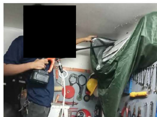
การทำความสะอาดเครื่องปรับอากาศพื้นที่ส่วนกลาง
