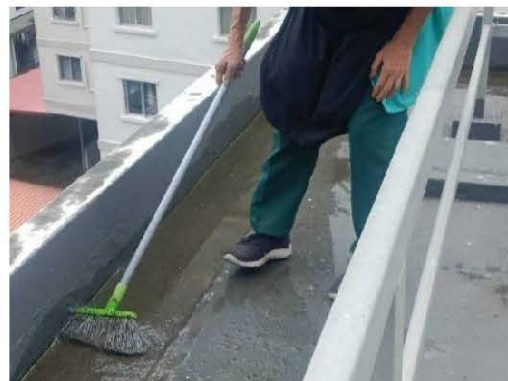
พนักงานขณะทำความสะอาดรางระบายชั้นหลังคา
