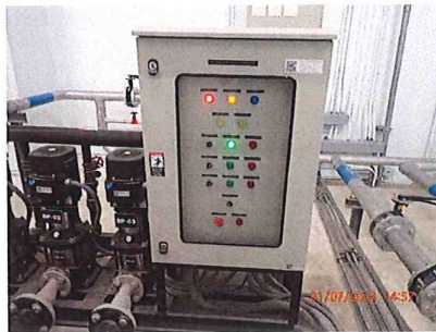
ภาพที่ 2.2-10 ระบบปั้มน้ำประปาชั้นใต้ดินและชั้นคาเฟ่
