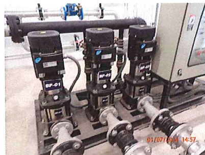
ภาพที่ 2.2-10 ระบบปั้มน้ำประปาชั้นใต้ดินและชั้นคาเฟ่
