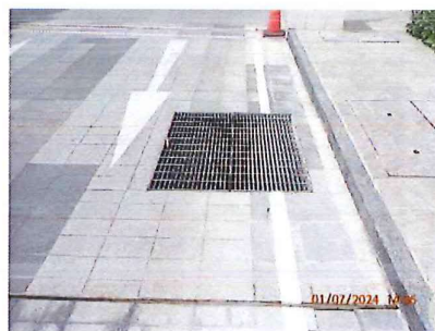
ภาพที่ 2.2-15 ระบบปั๊มบ่อน้ำและตะแกรงที่ระบายน้ำออกนอกโครงการ
