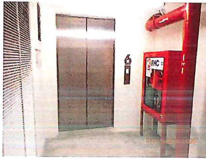
รูปที่ 1.8-5 ลิฟต์ดับเพลิง
