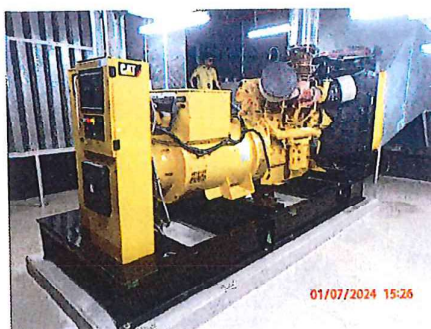
รูปที่ 1.7-2 ห้องเครื่องกำเนิดไฟฟ้าสำรอง (Generator)
