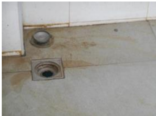
รูปที่ 2.4 ท่อระบายน้ำเสียจากห้องพักขยะเข้าสู่ระบบบำบัด
