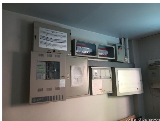
รูปที่ 2.17 Graphic Fire Alarm
