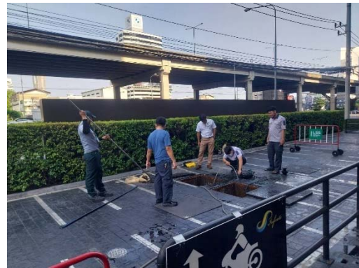
สูบน้ำจากระบบบำบัดน้ำเสีย
