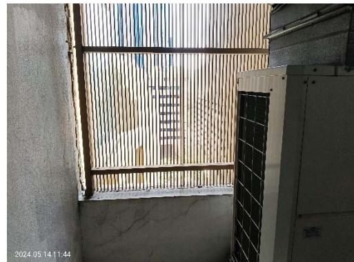
ช่องเปิดระบายอากาศของห้องเครื่องปรับอากาศแบบ VRF
